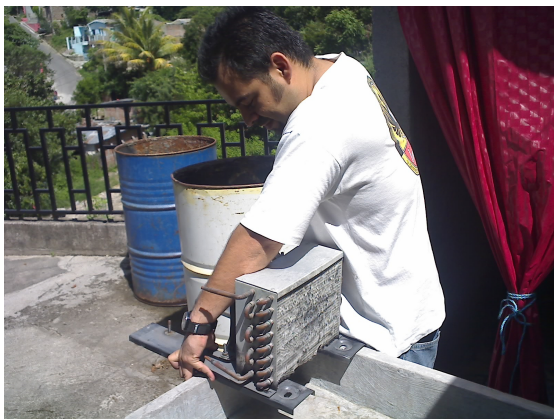
Fotografía 3: Preparación de accesorios
