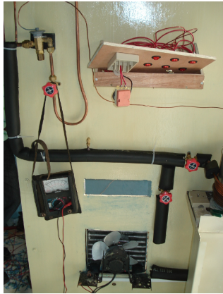
Fotografía 15: Preparación de sistema eléctrico
