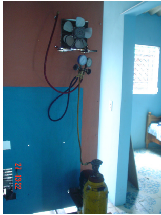
Fotografía 11: Procedimiento de limpieza a los intercambiadores
