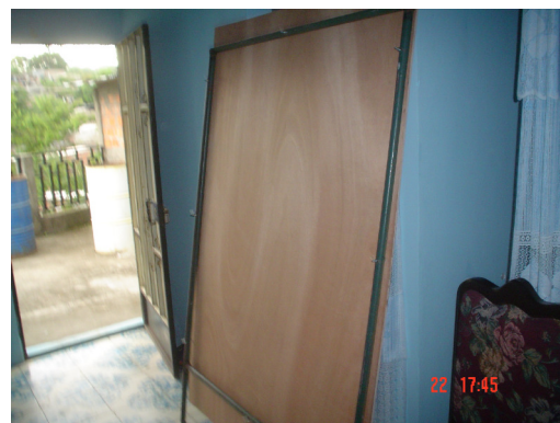
Fotografía 6: Ensamble de plywood con estructura metálica
