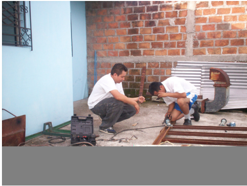
Fotografía 7: Preparación de base metálica
