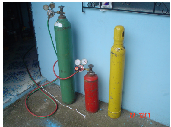
Fotografía 10: Equipo utilizado para soldar tubería de cobre
