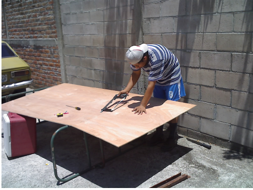
Fotografía 1: Corte de Plywood
