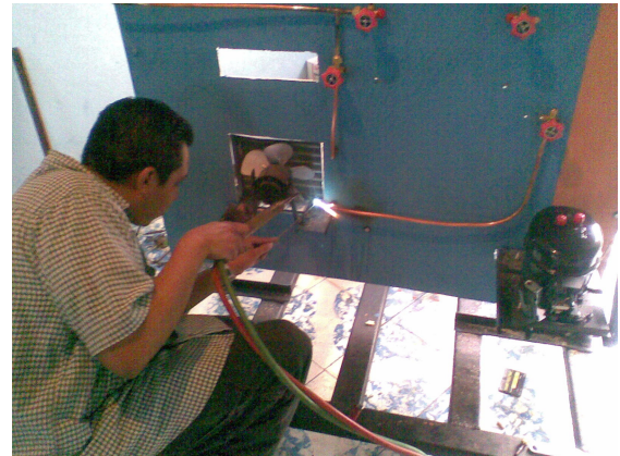
Fotografía 13: Procedimiento de soldar sistema de tuberías de cobre
