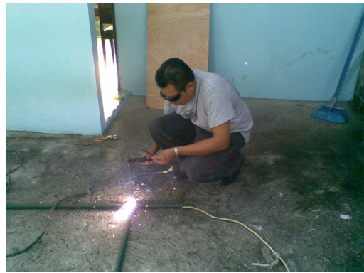
Fotografía 5: Preparación de estructura metálica
