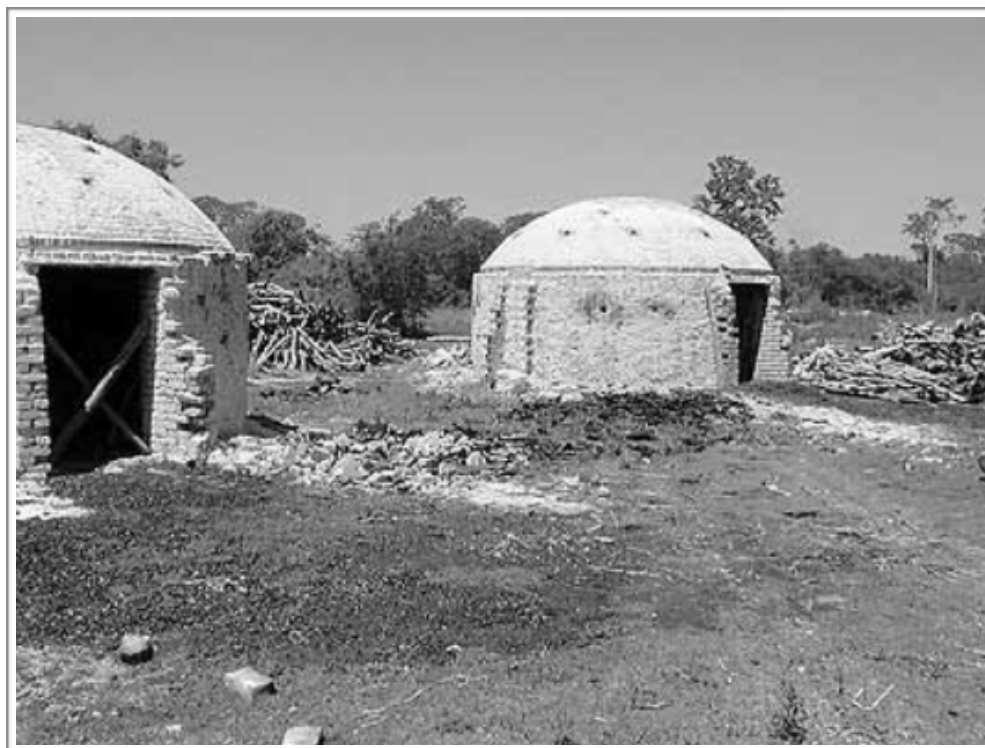
Imagen 5. Producción tradicional de carbón vegetal mejorada horno de ladrillo de tipo brasileño en Cuba
