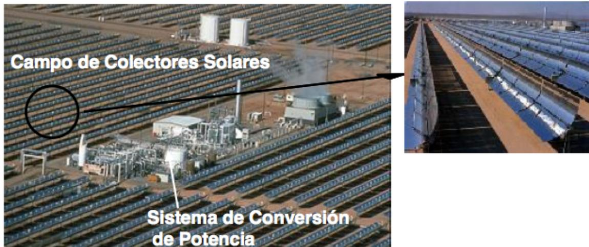
Figura 13: Vista general de una planta solar termoeléctrica con concentradores cilindro-parabólicos
