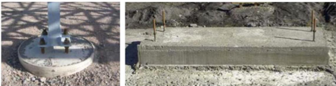
Figura A1. Cimentaciones de concentradores cilíndrico-parabólicos
