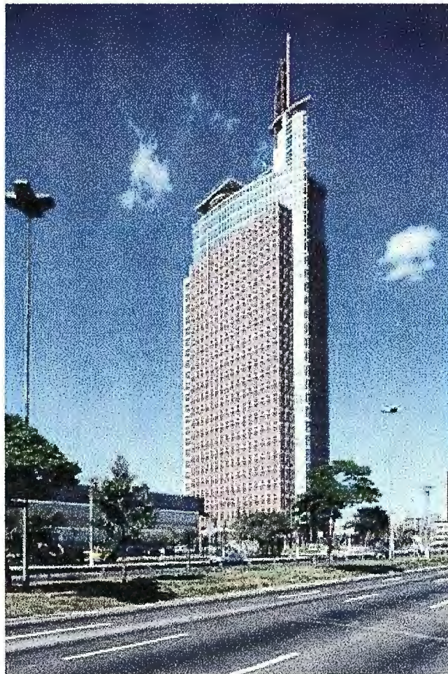
Figura 2.1 Edificio Birman Gran Bretaña
