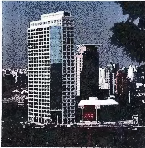
Figura 2.2 Edificio World Trade Center de Brasil
