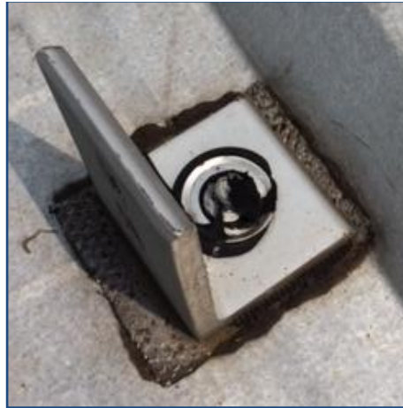
Figura 39: Ejemplo de instalación L impermeabilización anclada a polín encajuelado para cubierta metálica
