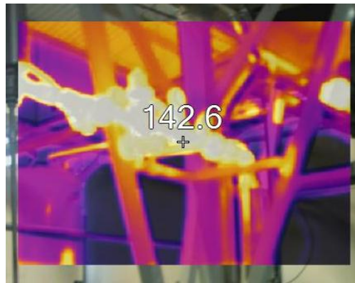
Entrada de vapor al Warmer
