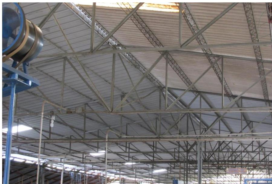
*Figura 5.2.1-2 Vista de la estructura que soporta el techo en el área de producción*
