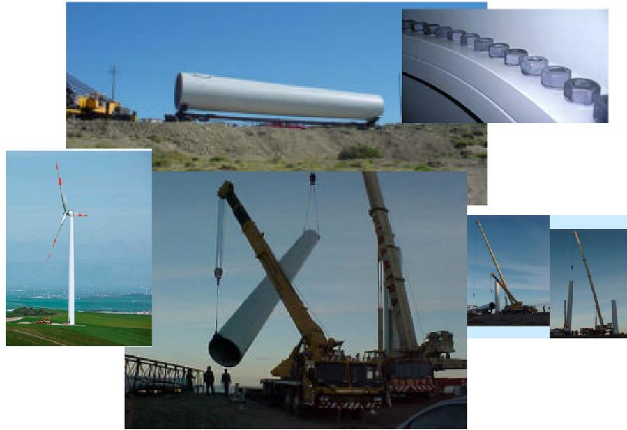
Fig. 1.40. Proceso de montaje y transporte de una torre tubular de acero [13].
