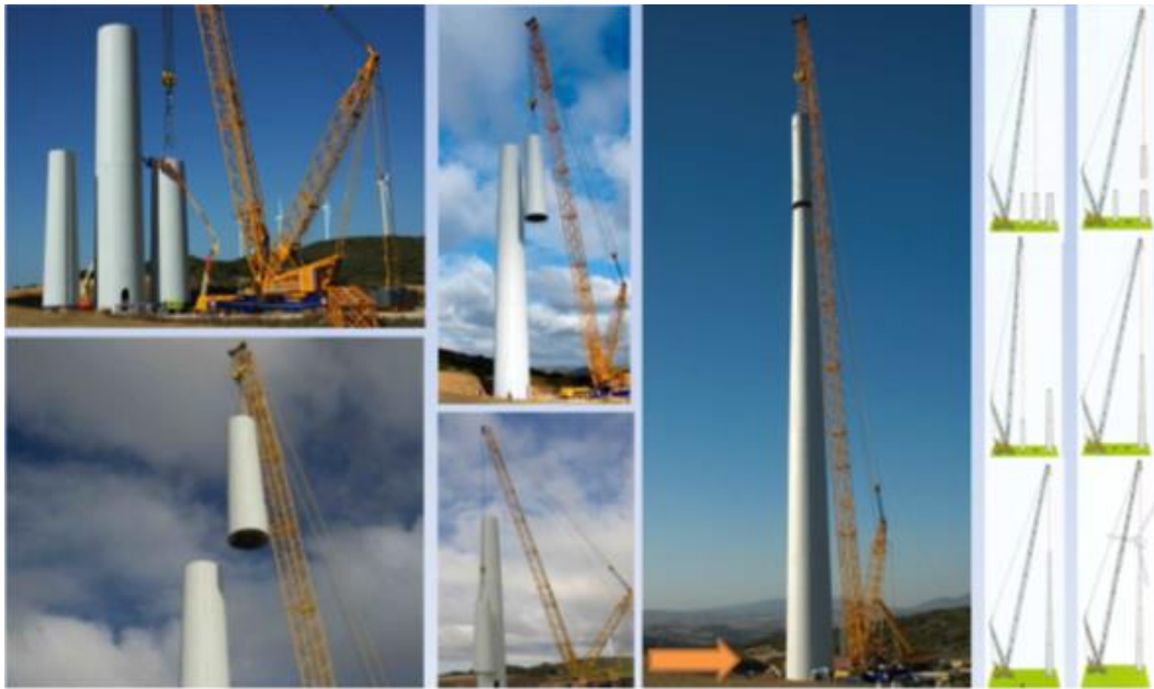
Fig. 1.41. Proceso de montaje de torres de concreto [13].
