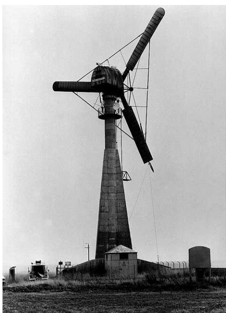
Fig. 1.4. Turbina Gedser construida en 1957 por J. Juul [4].
