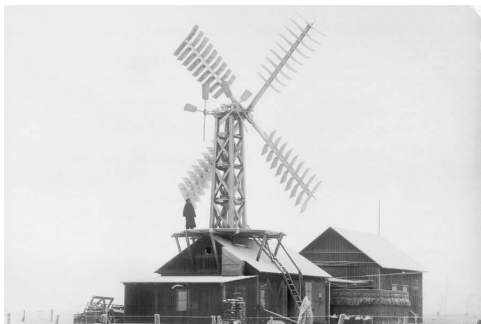
Fig. 1.3. El aerogenerador original de 1891 de La Cour tenía 11,6 metros (38 pies) de diámetro y condujo una dinamo de 18 kW a nivel del suelo (Fundación Poul la Cour) [2].
