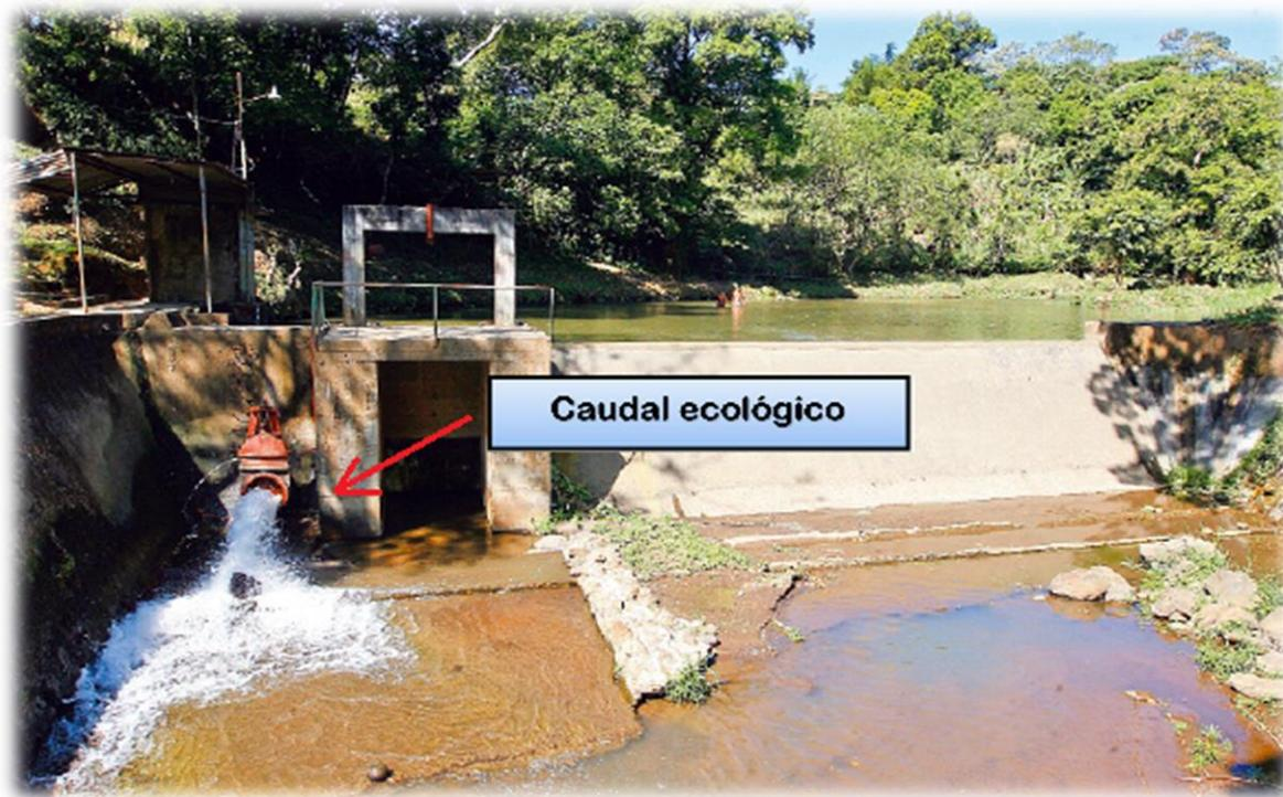
Figura 1. Caudal ecológico PCH Sensunapán. (Fuente: <http://www.laprensagrafica.com/sensunapan--una-minihidro-en-operación>).
