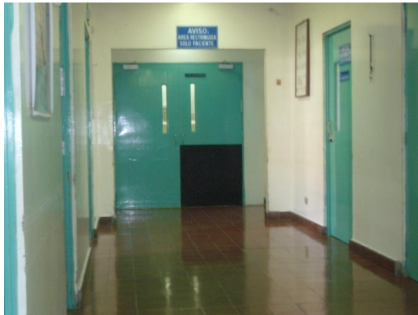
Figura 6.8: Puerta de entrada a Sala de Parto y Toco Quirófano.
