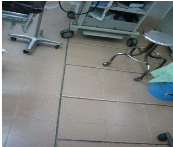
Figura 6.7: Pisos de la Sala de Parto y del Toco Quirófano.
