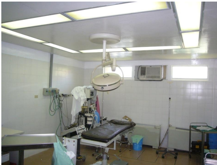
Figura 6.9: Techo de la Sala de Parto y Toco Quirófano.
