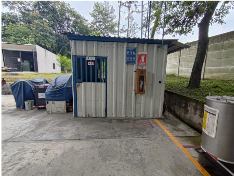
Figura 1.27. Fotografía externa del Cuarto/Bodega del Compresor y Filtro Coalescente Fuente: Fotografía tomada por el autor
