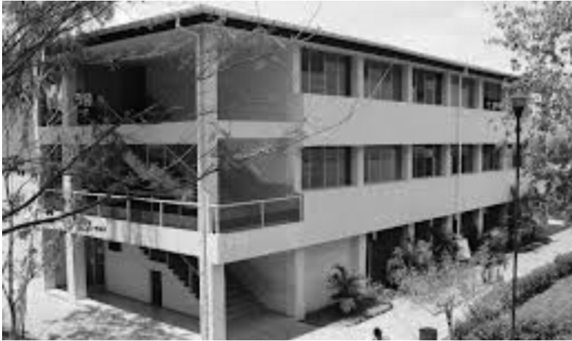
Imagen 6. Edificio de Aula Estándar "C".
