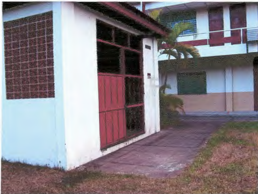
A10. Cuarto de Subestación #2 frente al Edificio 5 del CITT
