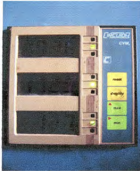
A1. Medidor Circutor CVMk empotrado en gabinete.
