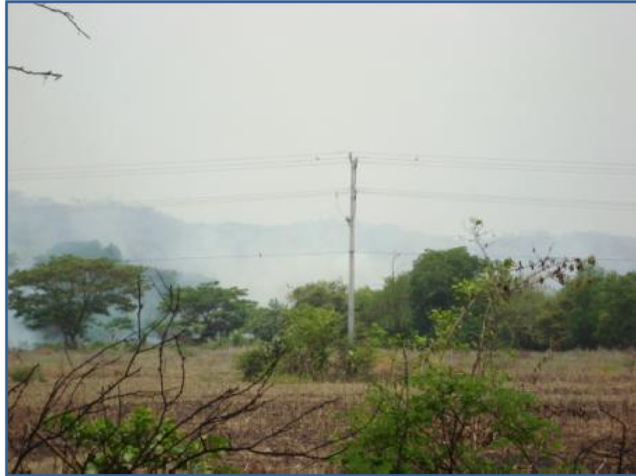
Fotografía 2. 5 Línea de red eléctrica en el Delirio 2
