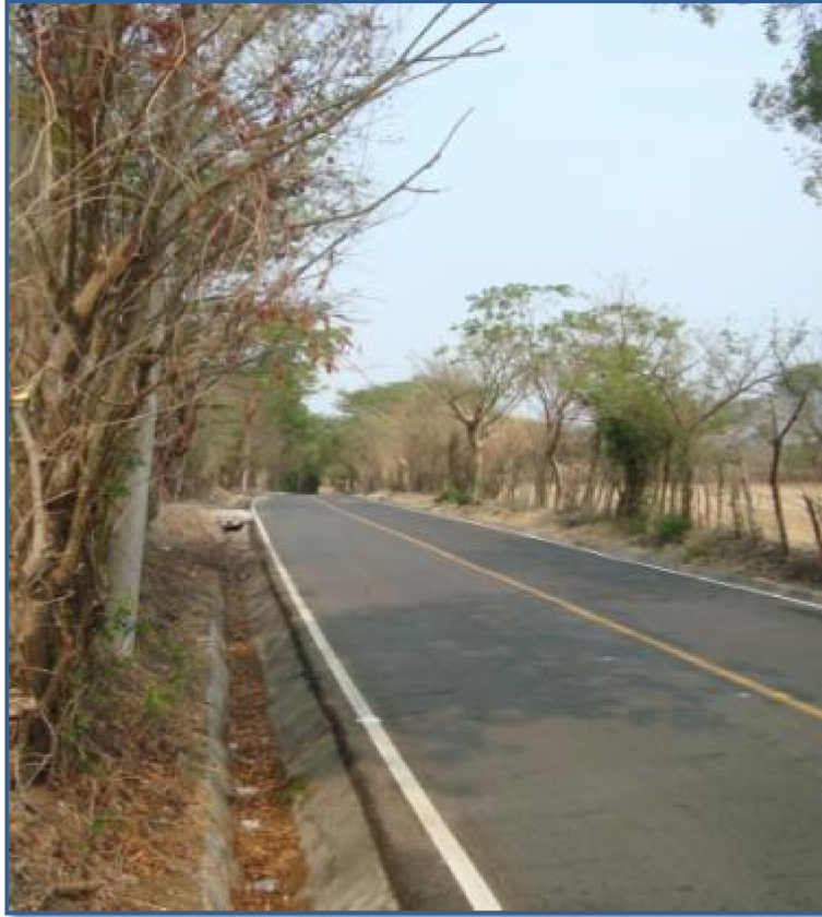
Fotografía 2. 12 Acceso red vial Chapeltique 2
