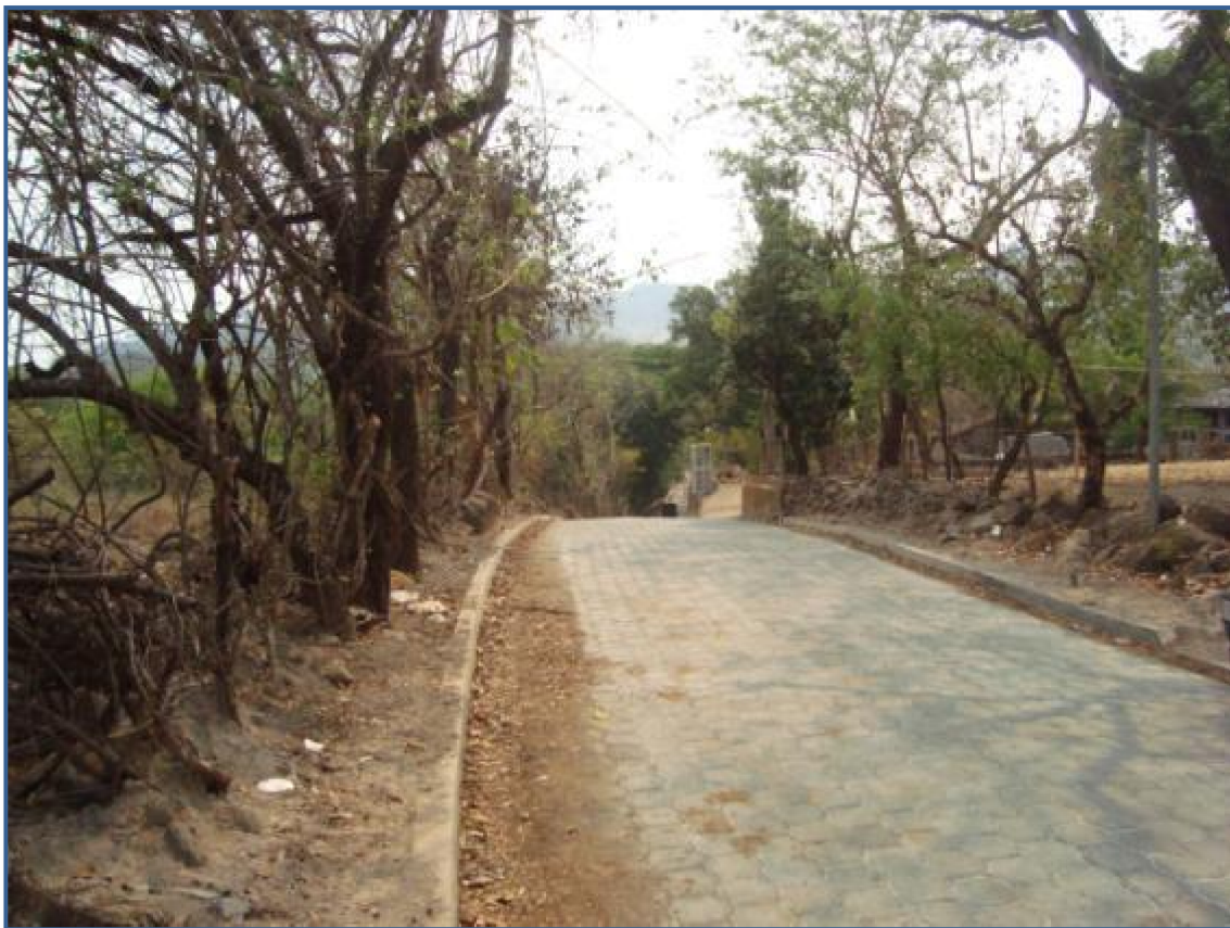
Fotografía 2. 9 Acceso red vial Chapeltique 1
