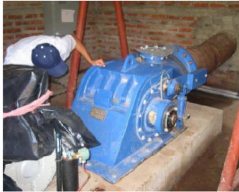
**Figura 43.** Turbina Michell-Banki de 34 kW instalada en Miracapa, Carolina, San Miguel.
