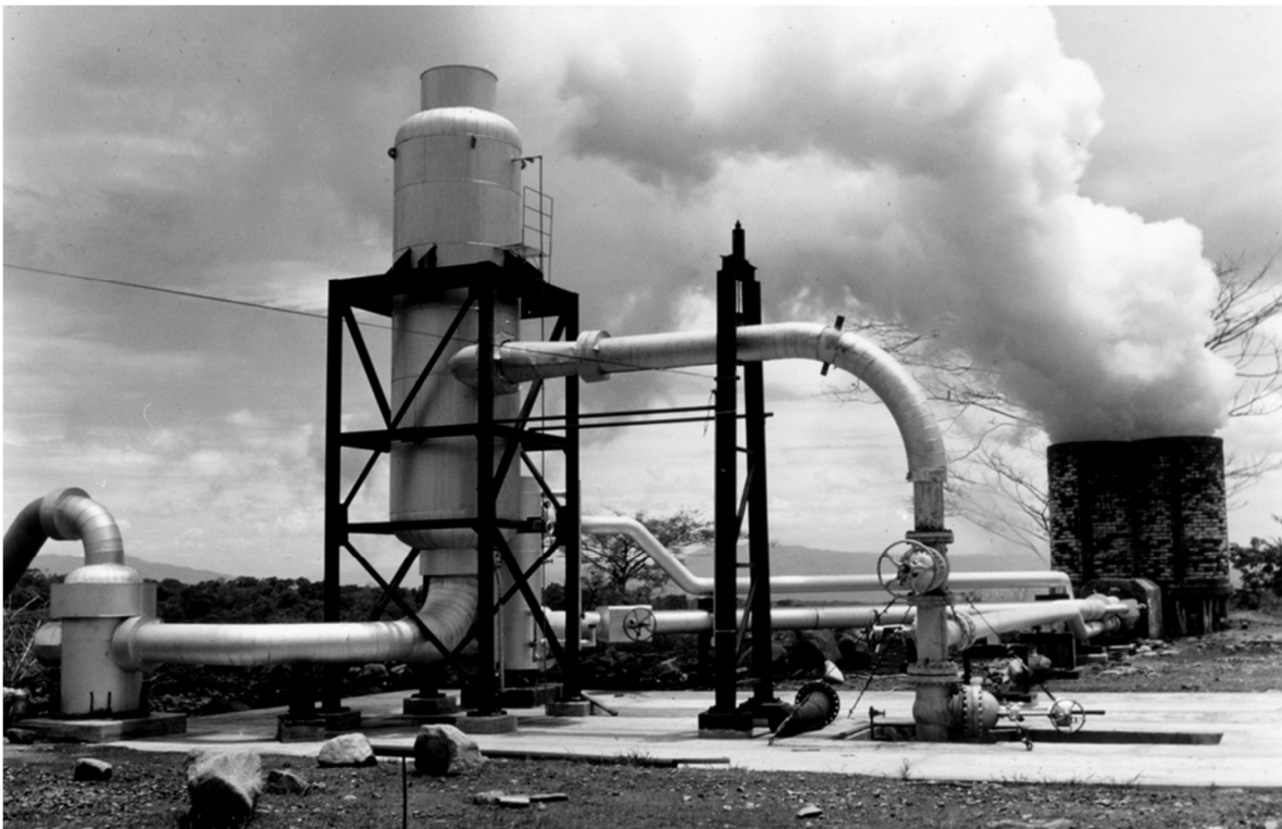
Figura 1: Separador ciclónico en pozo productor (DiPippo, 2016)
