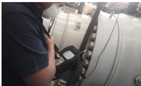
Figura 22. Toma de vibraciones mecánicas a reductores de velocidad
