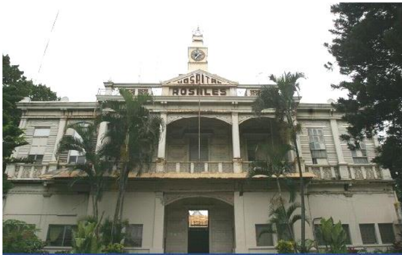
Fig. 3.1 Imagen de la fachada del Hospital Nacional Especializado Rosales.
