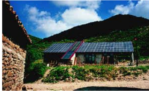
Fig. 1.6 Instalación de un sistema solar
