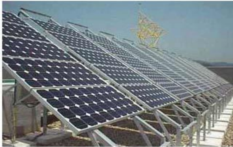
Figura 4.17 Instalación del panel solar.
