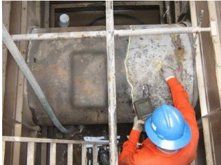
Figura 16. Inspección mediante ultrasonido industrial con haz recto. Fuente: Elaboración propia.
