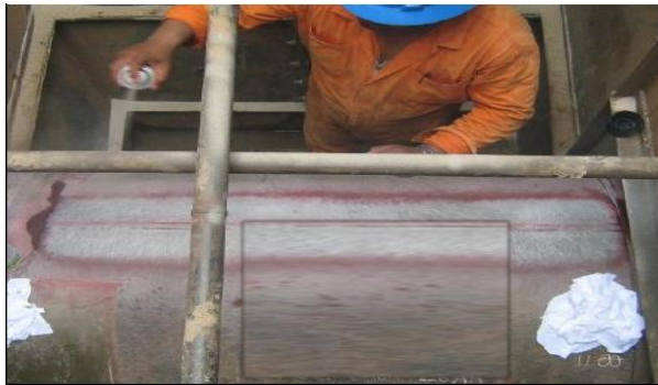
Figura 9. Aplicación de líquido penetrante en la zona a inspeccionar. Fuente: elaboración propia.
