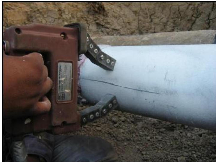
Figura 5. Aplicación de técnica de partículas magnéticas. Fuente: elaboración propia.
