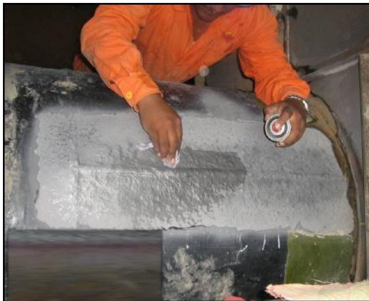
Figura 7. Limpieza mediante aplicación de líquido removedor. Fuente: elaboración propia.
