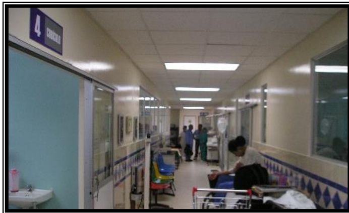
Fotografía No. 5 - Pasillos y Luminarias
