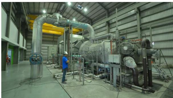
Figura 41. Turbo generador. [Fuente: [historico.elsalvador.com/historico/439746/como-se-transforma-el-bagazo-de-cana-de-azucar-a-energia-electrica.html](https://historico.elsalvador.com/historico/439746/como-se-transforma-el-bagazo-de-cana-de-azucar-a-energia-electrica.html)]
