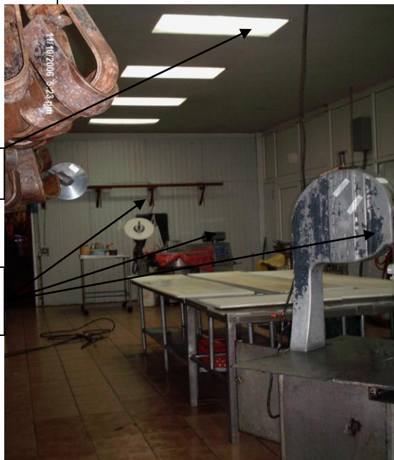
Luminarias del Área de Corte
