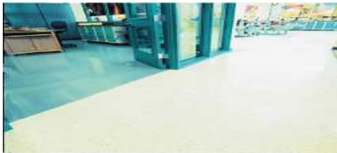
Figura 4.15. Vista Piso Terminado
