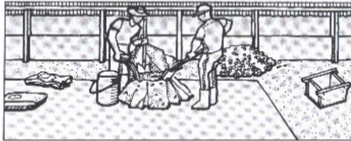
Figura 18. Adición del agua a la mezcla
