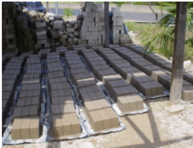
Figura 9. Colocación de los bloques para el curado
