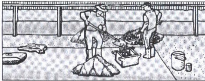
Figura 16. Dosificación del material grueso
