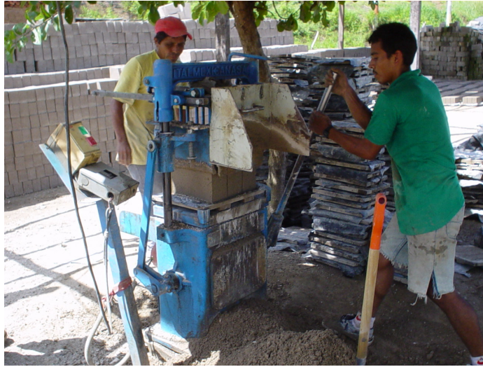
Figura 23. Retiro de los bloques
