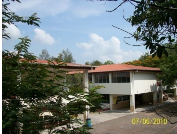
Figura 2.31, Izquierda aulas estándar B, derecha aulas estándar A
