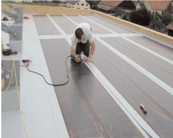
Figura 3.37 Montaje de módulos flexibles
