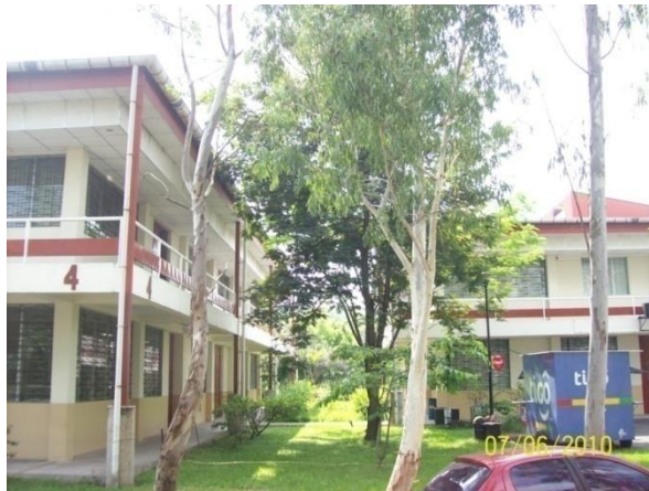
Figura 2.37, Izquierda edificio 4, derecha edificio 5
