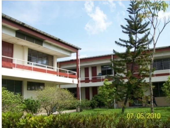
Figura 2.36. Izquierda edificio 4, derecha edificio 3. La diferencia de nivel considerada es de 1.5 metros.
