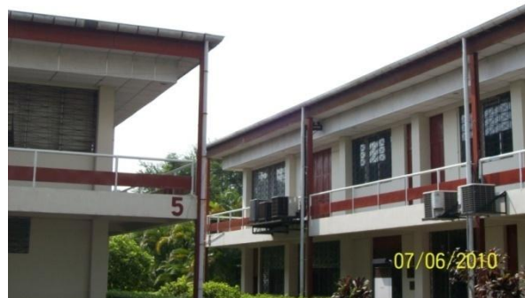
Figura 2.38, Izquierda edificio 5, derecha edificio 6
