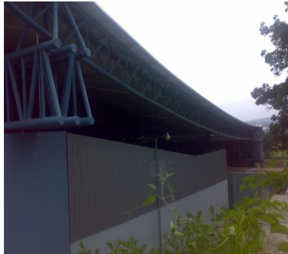
Figura 3.12 Vista del techo del multigimnasio
