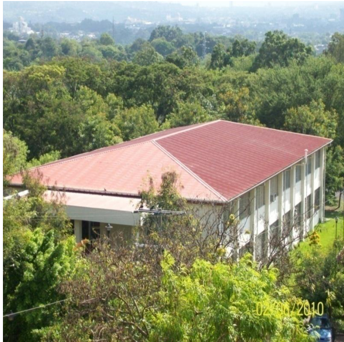
Figura 2.9 Techo Edificio Ortesis y Prótesis
