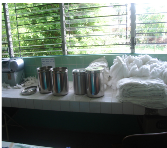
Imagen 7.39 Ventanas en el Área Negra, que permiten tanto ventilación como iluminación natural.
