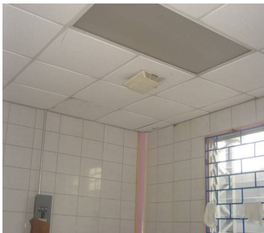
Imagen 7.23 Detalle de Cielo Falso y paredes de la Central de Esterilización
