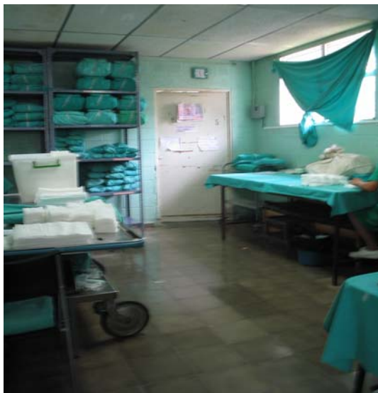
Imagen 7.47 Cielo falso de las áreas de Curaciones y Preparación de paquetes
