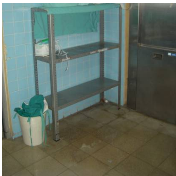
Imagen 7.16 Piso dañado área de esterilizadores
