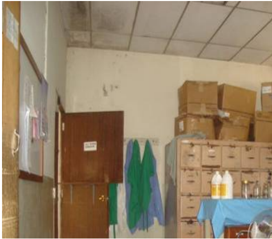
Imagen 7.4 Cielo falso de las áreas de jefatura y de Almacenaje de material estéril dañado debido a humedad.
