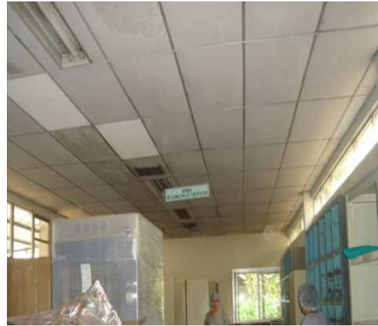
Imagen 7.4 Cielo falso de las áreas de jefatura y de Almacenaje de material estéril dañado debido a humedad.
