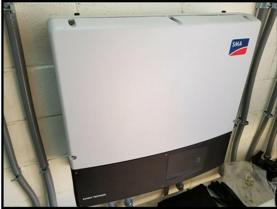
Figura 19. Inversor SMA Sunny Tripower en Instalación "El Angel".
