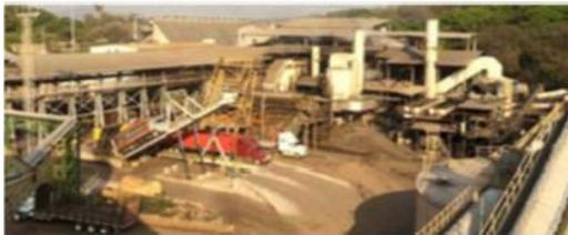
LA CAÑA ES ALIMENTADA HACIA EL MOLINO UTILIZANDO MESAS Y CONDUCTORES, QUE POSEEN UNA COMBINACION DE CUCHILLAS CORTADORAS, PICADORAS Y DESFIBRADORAS, QUE TIENEN COMO FINALIDAD ACONDICIONAR LA CAÑA PARA OBTENER MAYOR EXTRACCION DE SACAROSA EN LOS MOLINOS
