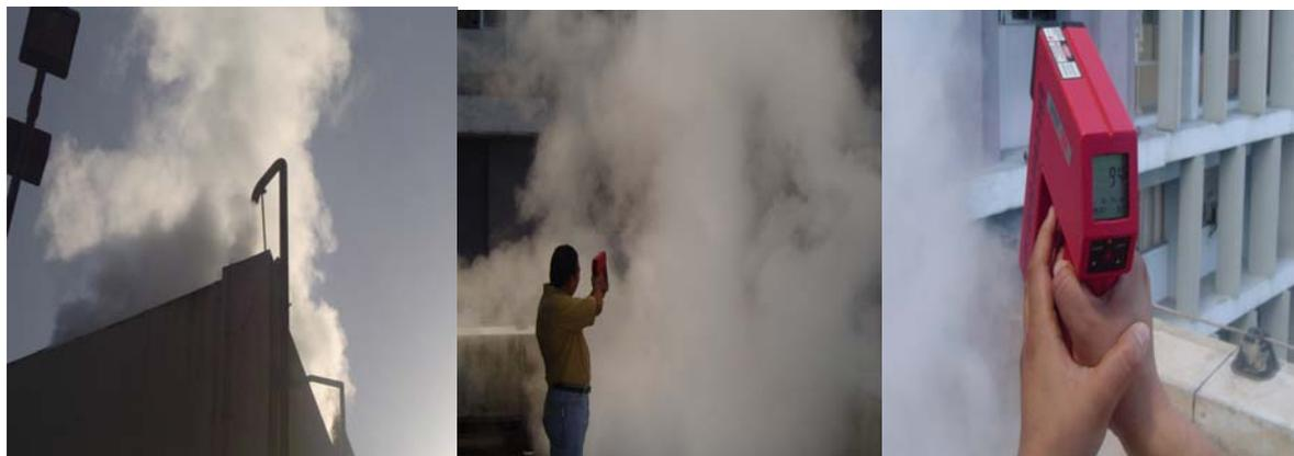
Figura 4.2 Fuga de vapor vivo a través de tubería de venteo.
