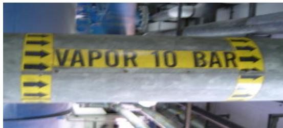
Figura 2.15 Tubería de suministro de vapor.
