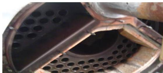
Figura 2.14 Estructura interna de una caldera.
