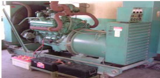
Figura 2.17 Planta de Emergencia.
