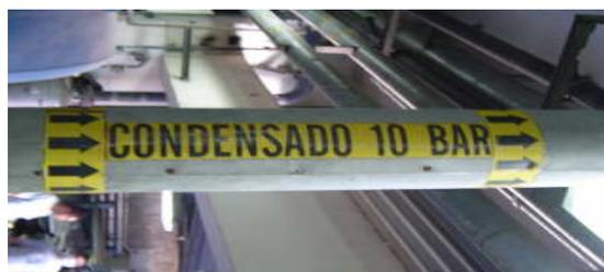
Figura 2.16 Tubería de Retorno de Condensado.
