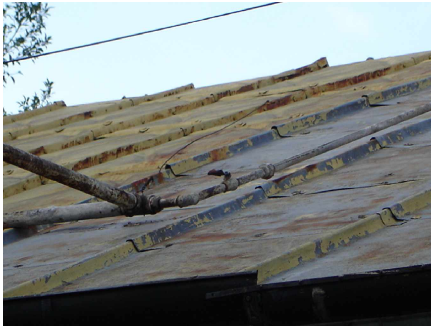
Fotografía 6. Tubería sin aislante, tramo que conduce a central de equipo y fabrica de suero
