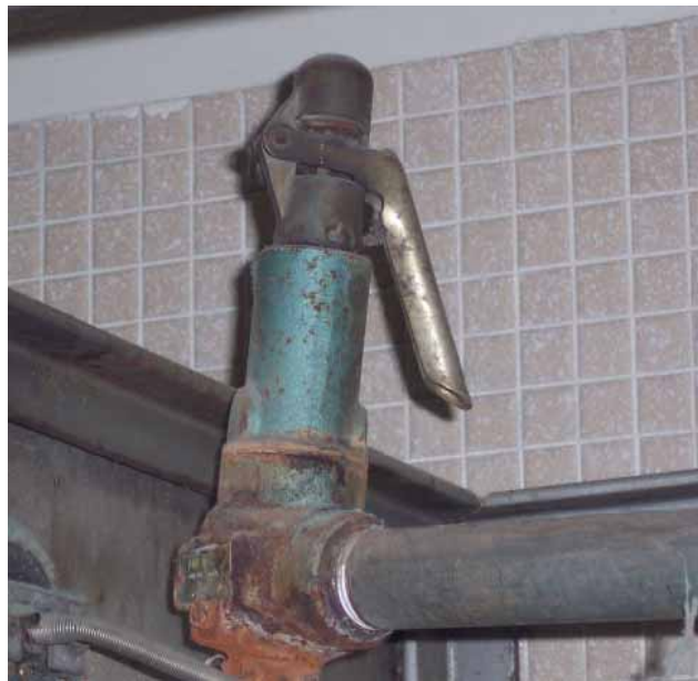
Figura 3.11. Válvula de Alivio Tipo Ferrocarril.
