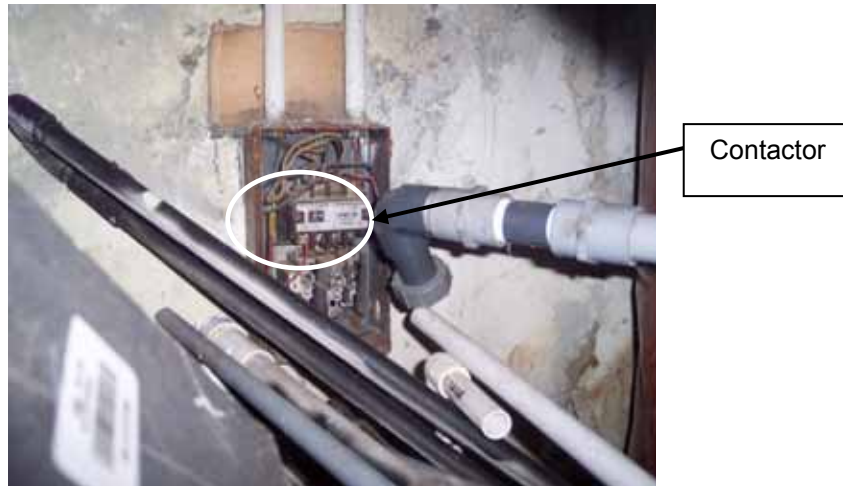
Figura 3.28. Contactor Responsable Manejo del Combustible.
