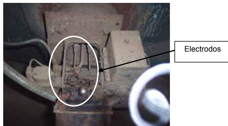
Figura 3.33. Electrodo Generadores de Arco Eléctrico.
