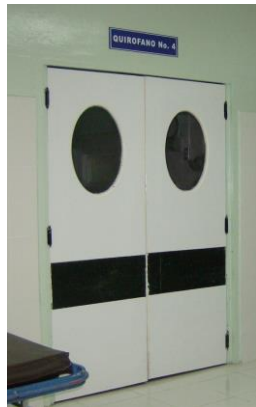
Figura 4-10: Puerta de entrada a quirófano.
