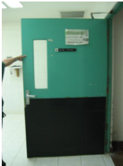
Figura 4-5: Puerta de entrada a quirófano.
