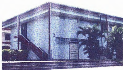
Foto 2. El centro de Comunicaciones.
