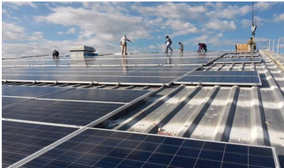
Figura 2.9 Módulos fotovoltaicos montados directamente en el techo o en alguna estructura cercana a la superficie del techo.
