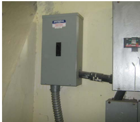
FIGURA 1.29. Subtablero para secadora.
