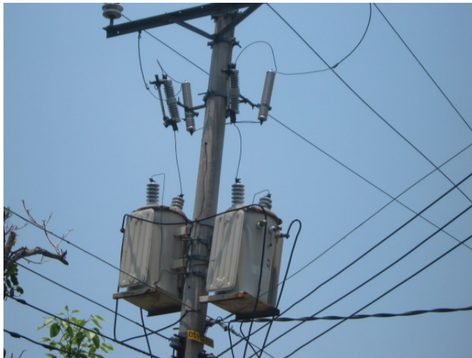
FIGURA 1.26 Subestación Estrella Abierta- Delta Abierta cuatro hilos.
