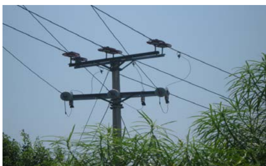
FIGURA 1.1. Entronque de la distribuidora
