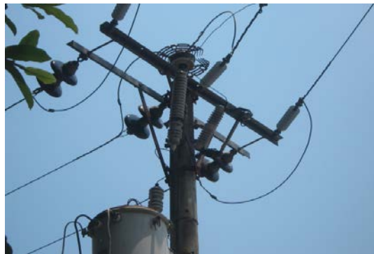
FIGURA 1.34. Estructura primaria para subestación monofásica de 50 kVA.
