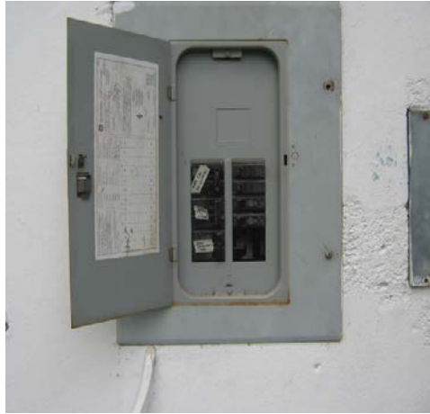
FIGURA 1.20 Tablero del Edificio A.
