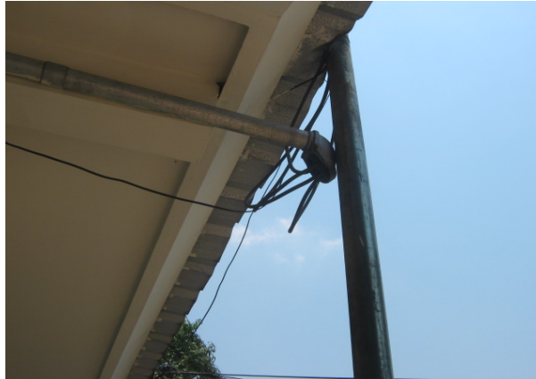
FIGURA 1.41. Acometida de salida del grupo Electrónico.
