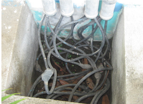
FIGURA 1.42 Pozo de registro para la transferencia.
