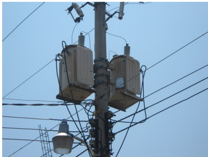
FIGURA 1.27. Vista del montaje de la subestación y las acometidas aéreas.
