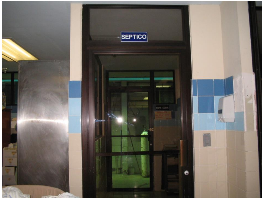
Cuarto séptico y de almacenamiento de materiales de limpieza
