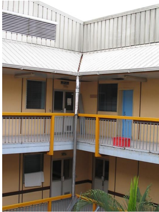
Puerta de desechos y de entrada de visitantes.
