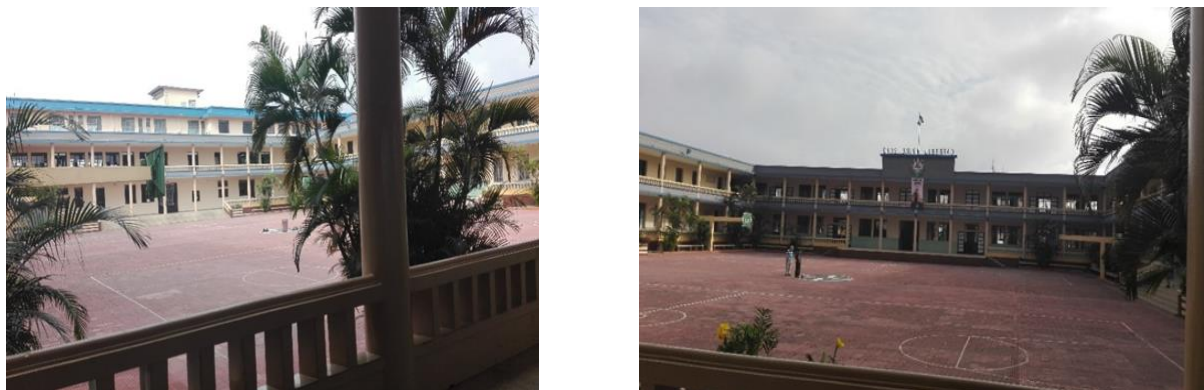
Figura 3: Infraestructura Interna del Colegio Liceo Salvadoreño. Fuente: Tomada por el equipo de Investigación.
