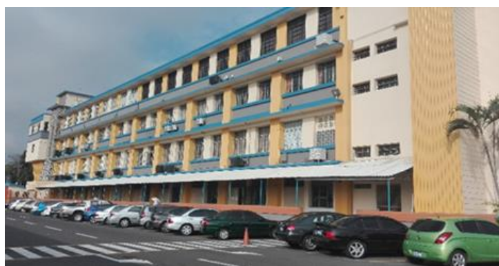
Figura 4: Edificio Central Colegio Liceo Salvadoreño .Fuente: Tomada por el equipo de Investigación.
