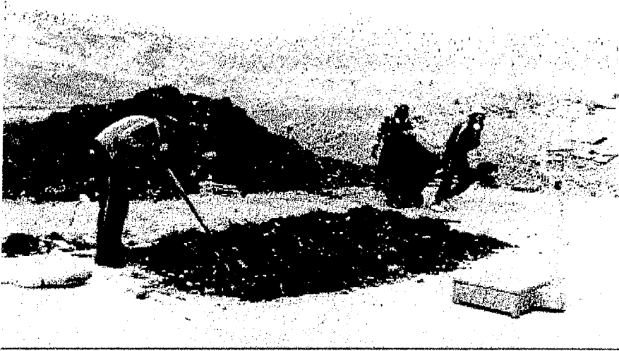
FOTOGRAFIA N° 3 : Formación de la primera pila con residuos pesados sobre la losa
