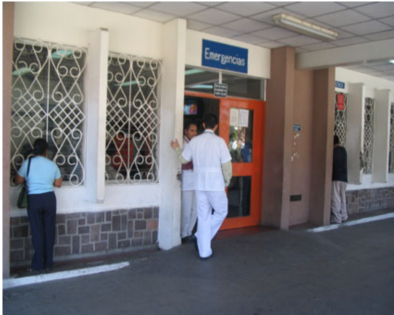
Fig. A-1 Entrada principal de La unidad de emergencia
