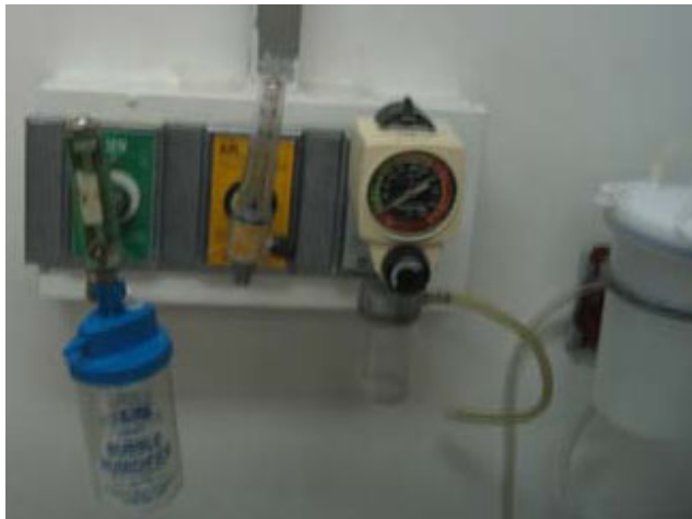
Fig. A-7 Tomas de Gases Médicos Máxima Urgencia
