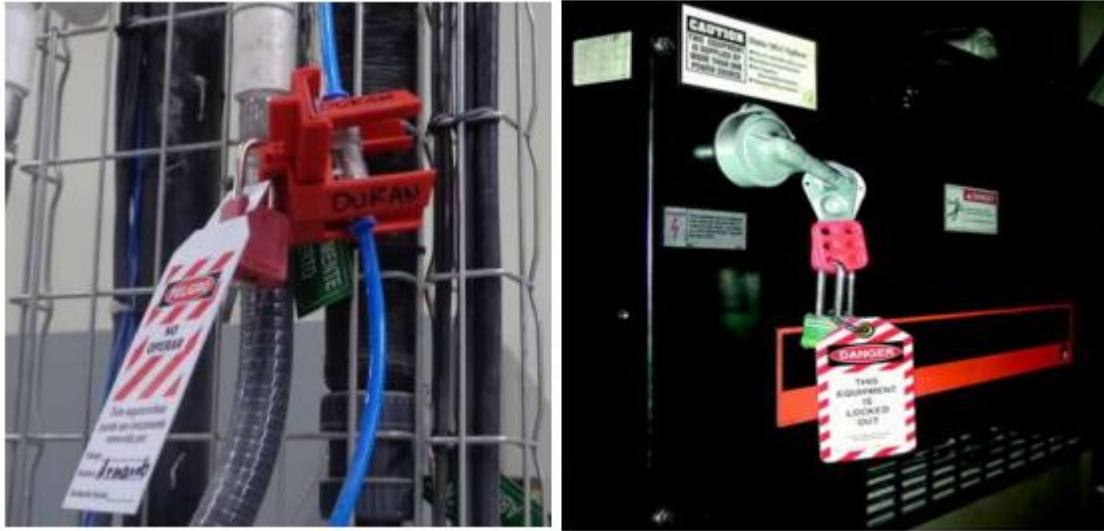
Figura 32. Ejemplo de bloqueo y etiquetado en la empresa industrial. Fuente: Elaboración propia
