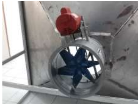
Fig. 5a. Instalación de motor eléctrico
