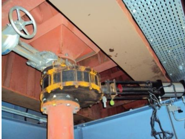
Ilustración 14. Válvulas de descarga de lecho fluidizado
