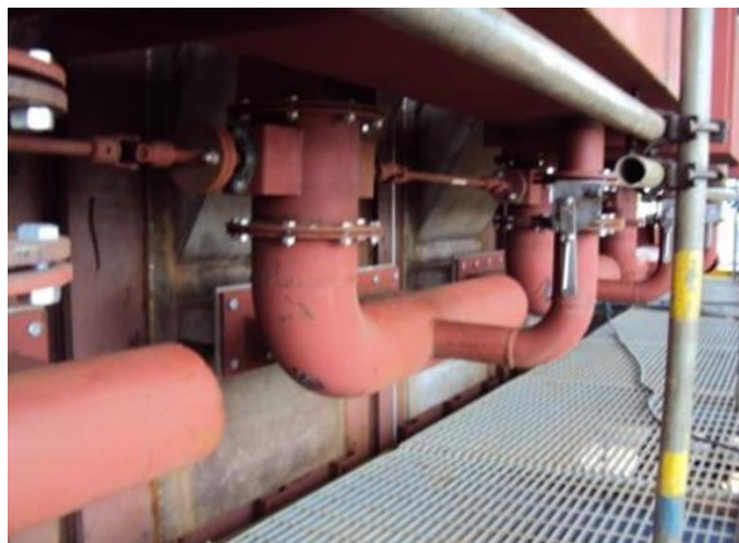
Ilustración 8. Tolvas de alimentación de combustible
