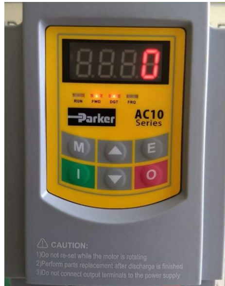
Ilustración 2. Variador de frecuencia Parker
