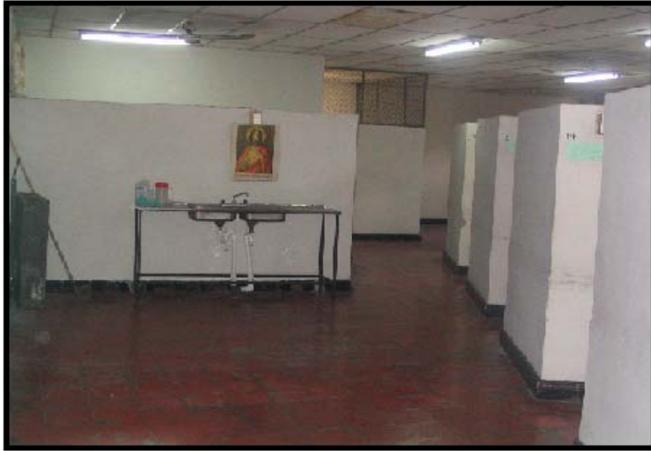
Figura 7.2: Vista panorámica del área de aplicación de Braquiterapia del Hospital Rosales
