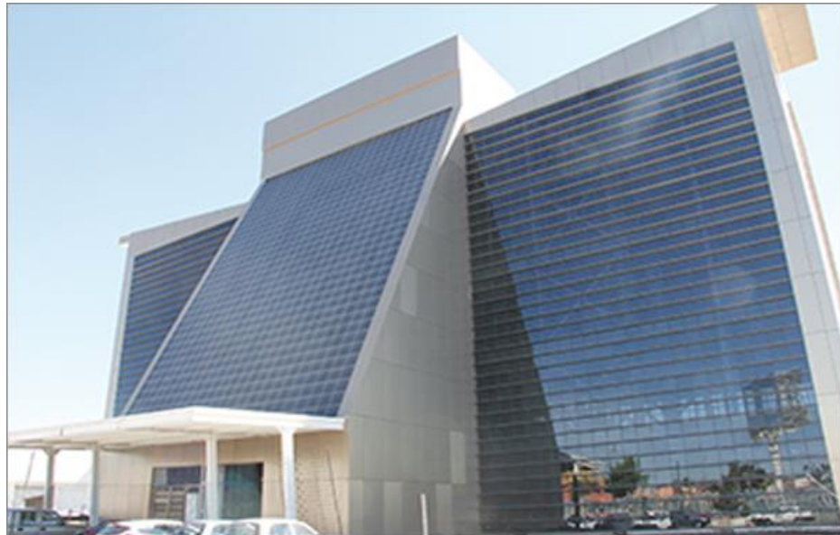
Figura 9: Edificio objeto del caso de estudio. (Fuente: plataformaptec.es)
